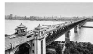
武汉长江大桥长约1670米。
