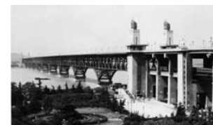
南京长江大桥铁路桥 长约6772米。
